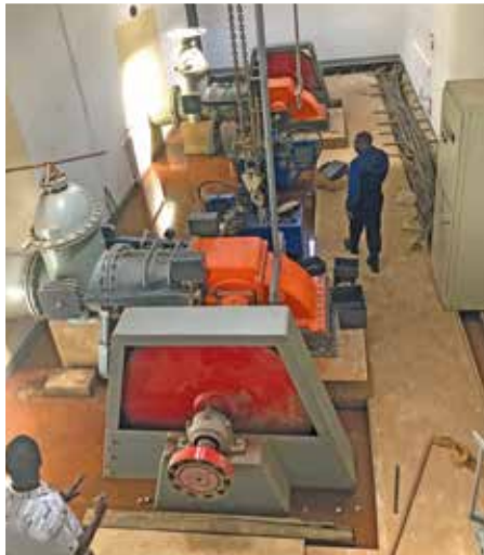
Das frisch renovierte Turbinenhaus
